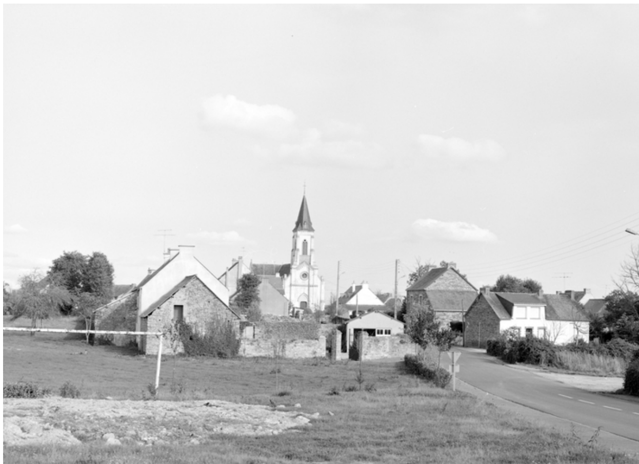
Église : vue de situation ouest (état en 1983)
