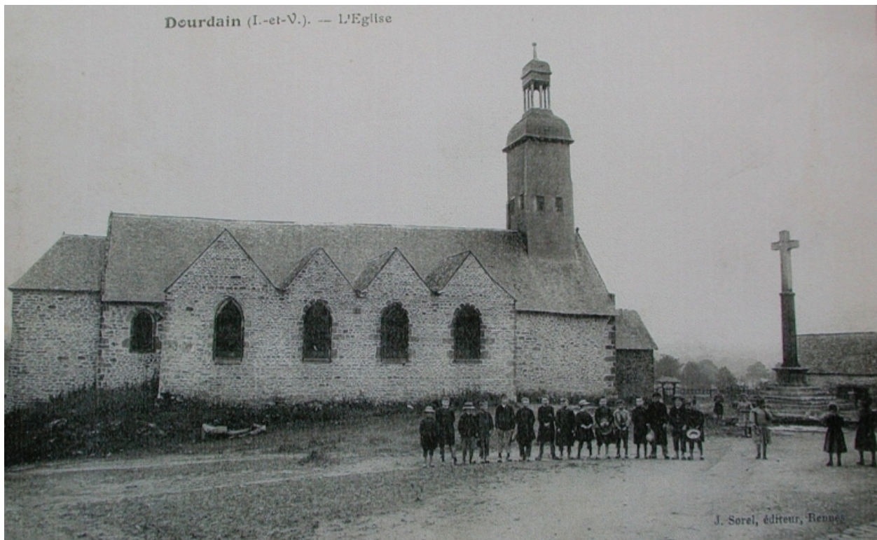
Carte postale du début du 20e siècle, façade latérale
