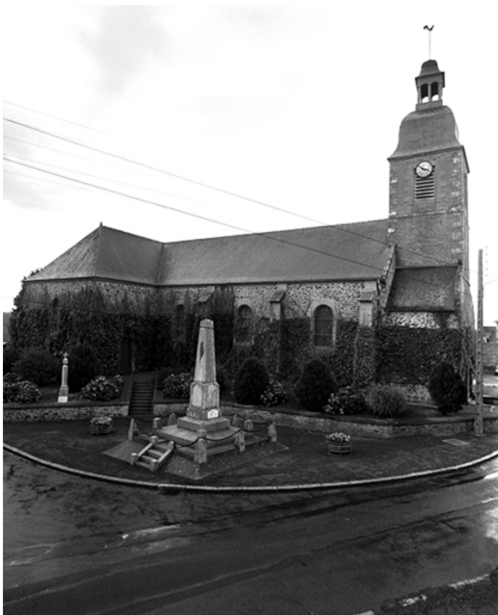
Vue générale nord
