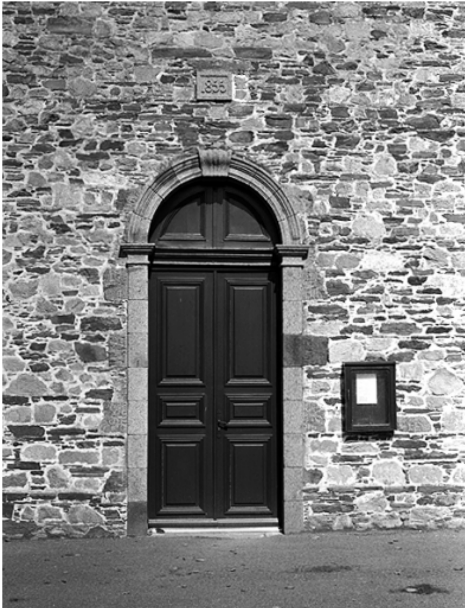
Elévation sud, porte ouest : vue générale
