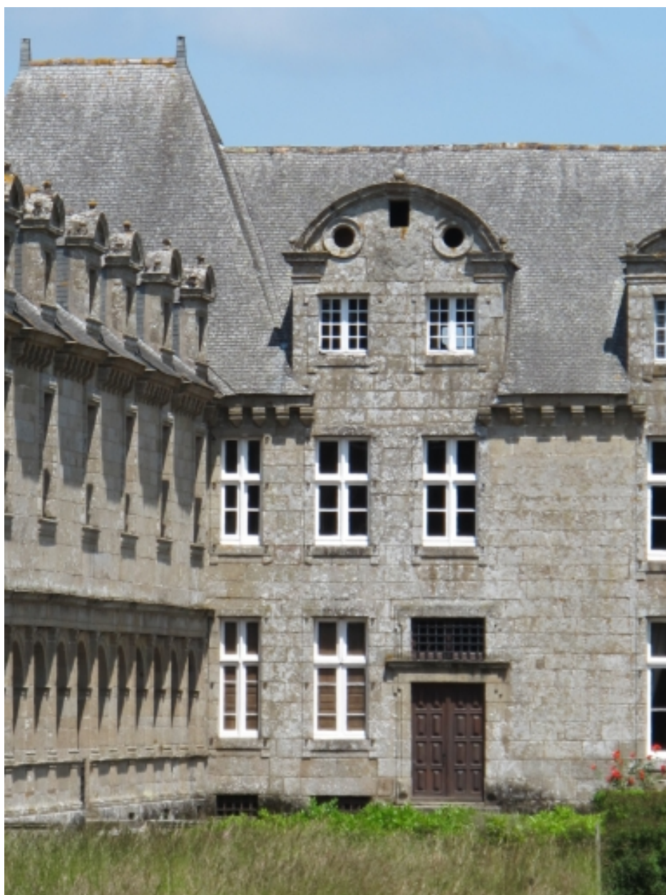
Détail des ouvertures, façade principale
