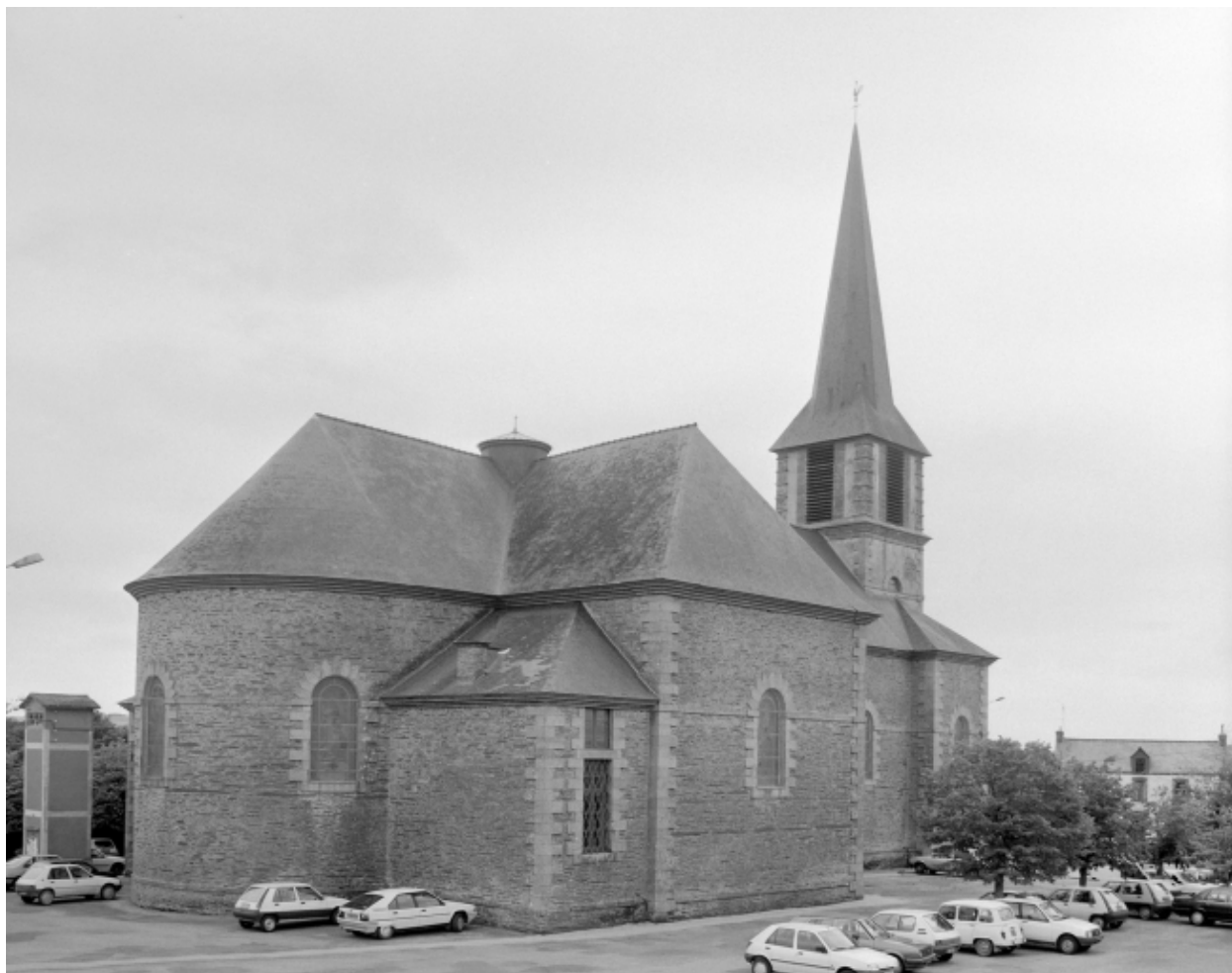
Elévation nord-est : vue générale
