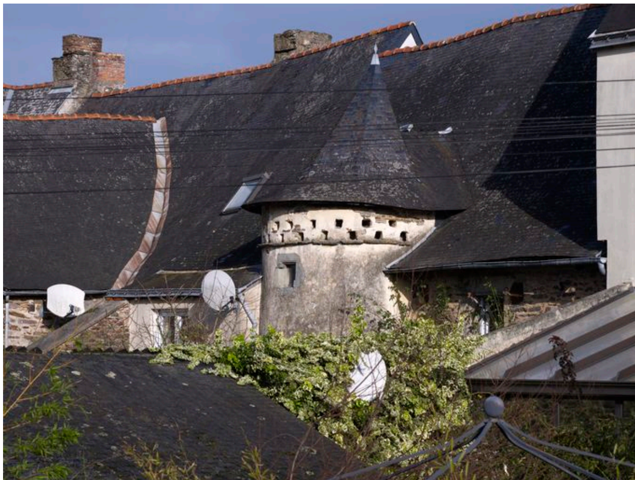
Maison, élévation postérieure : le pigeonnier (état en 2012)
