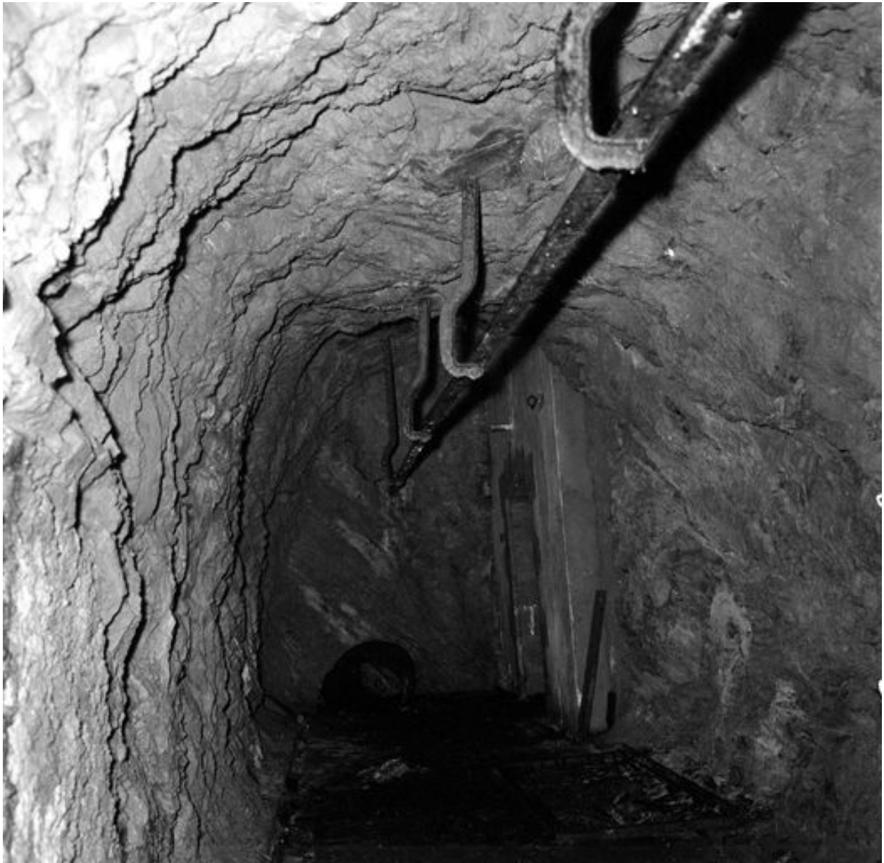
Vue de la batterie du Toulinguet en 1969 : escalier d'accès du magasin à poudre sous roc. A signaler : monorail pour le transport de munitions
