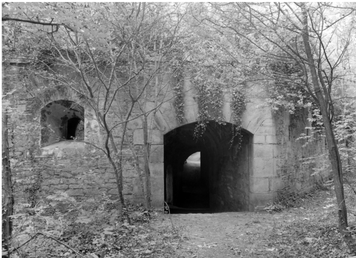
Le Palais, enceinte urbaine, réduit G, flanc droit, état dans les années 1970.
