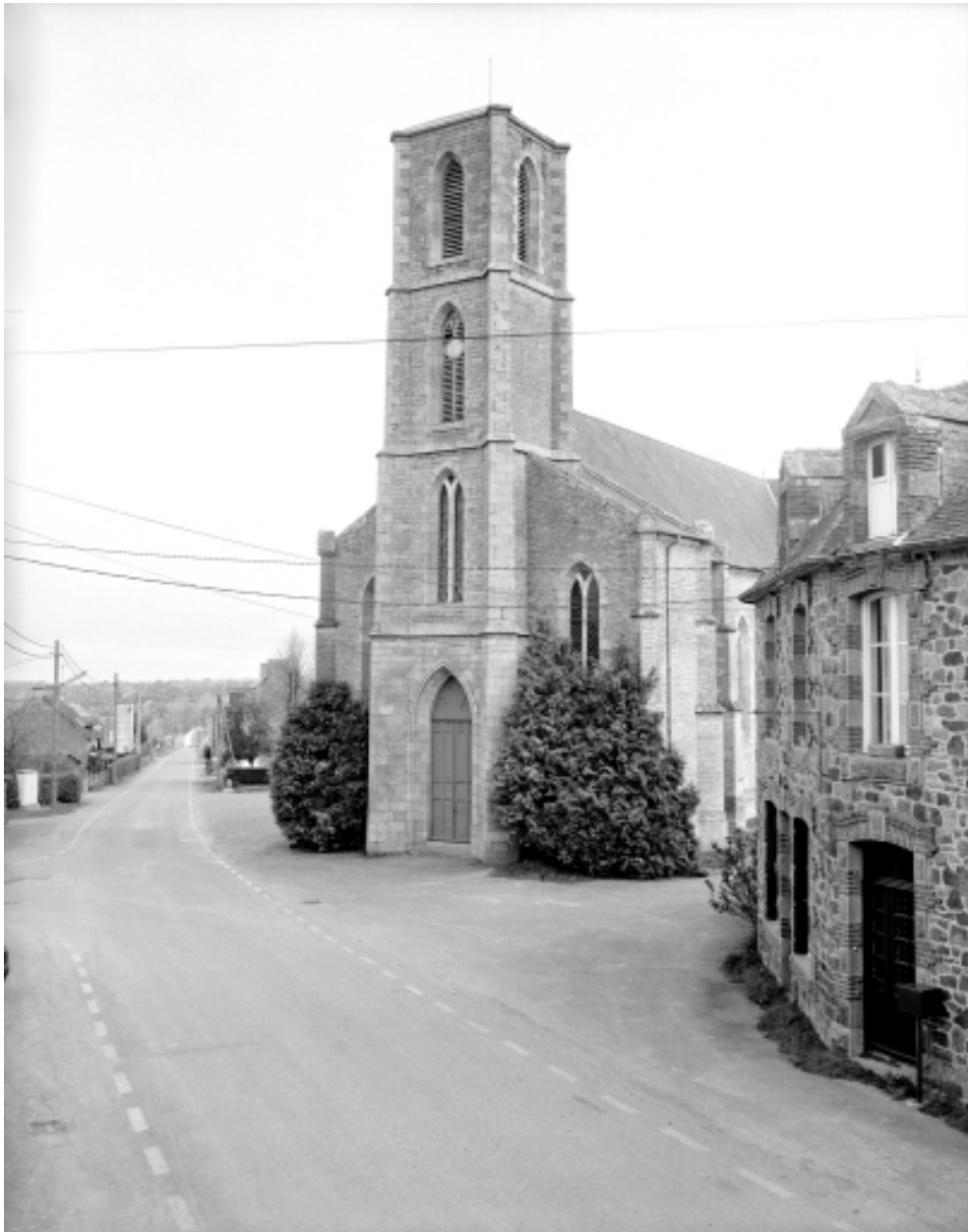
Elévation Sud-Ouest : vue générale
