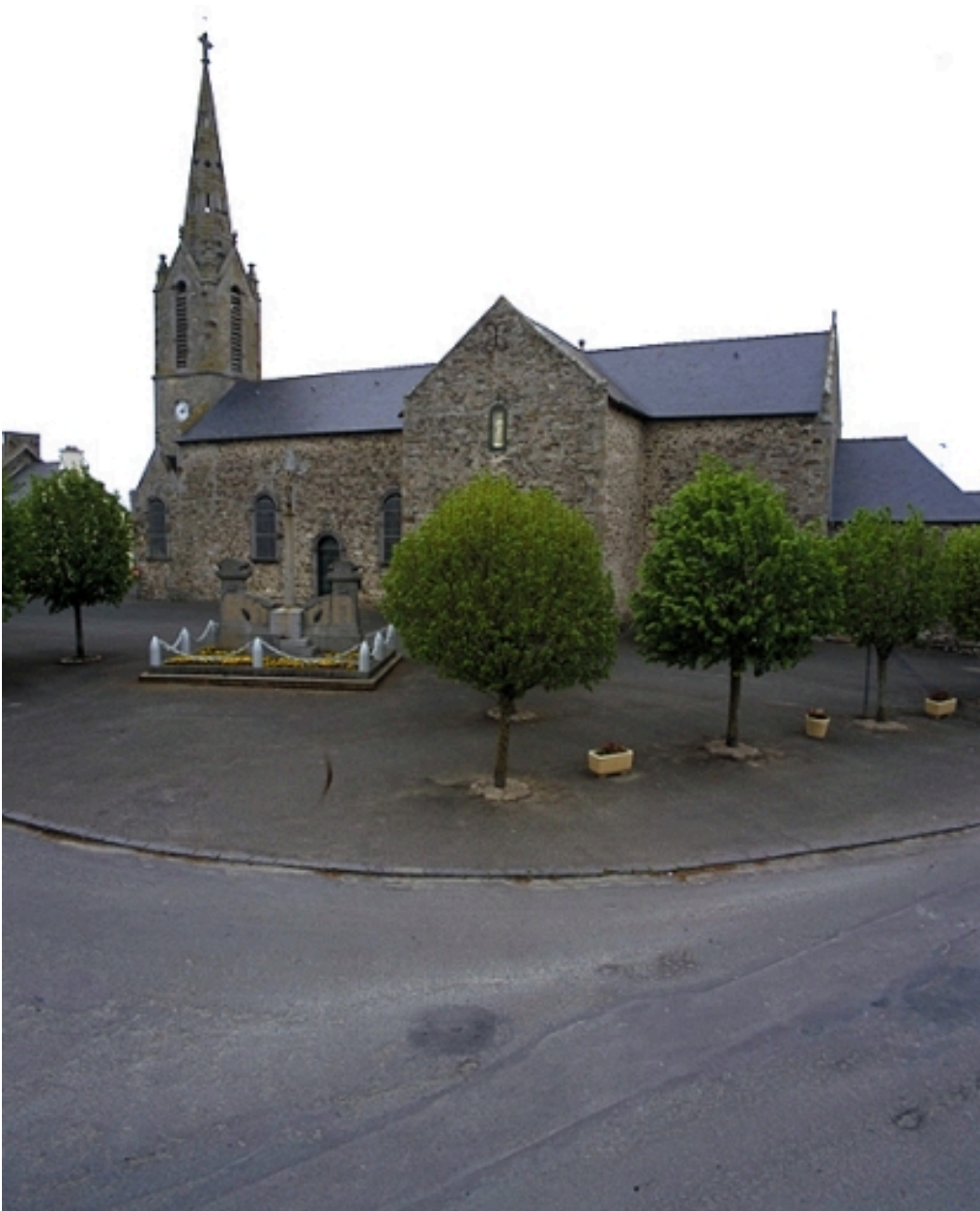
Vue générale sud-est
