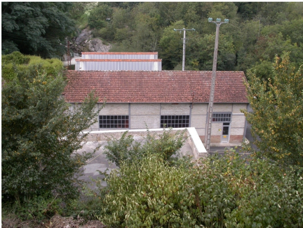
La salle des machines, façade nord-est.
