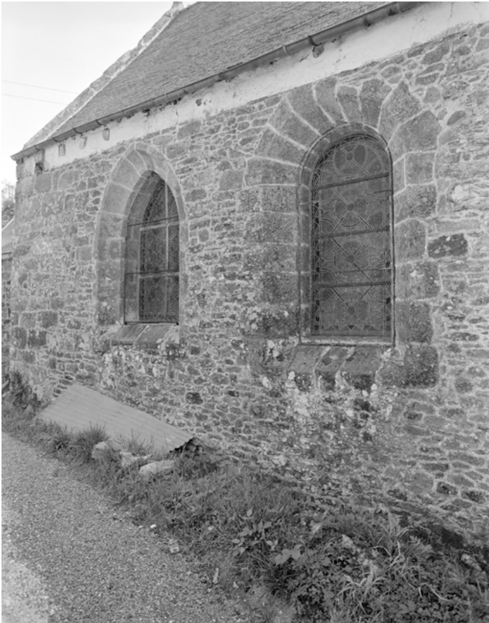
Fenêtres 1 et 2 du choeur, mur nord
