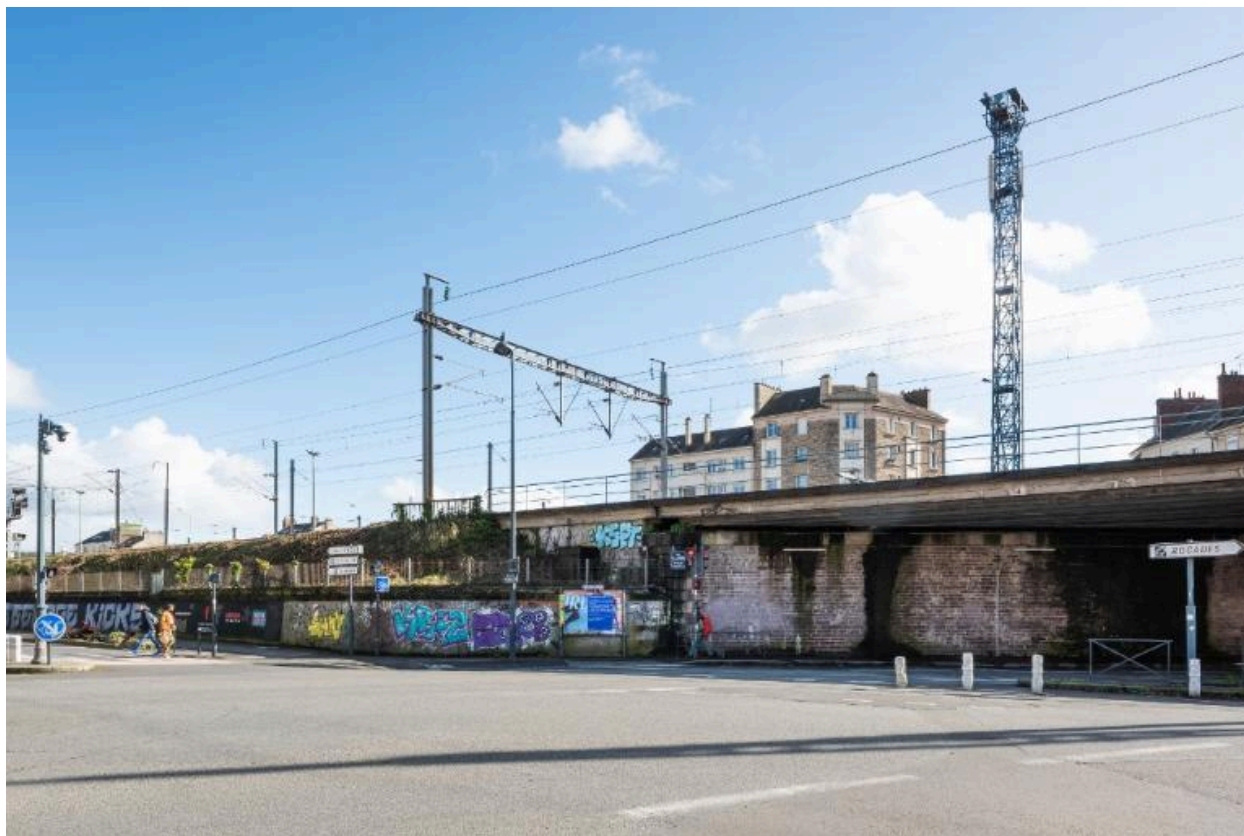
Vue de la voie ferrée et de la culée est.
