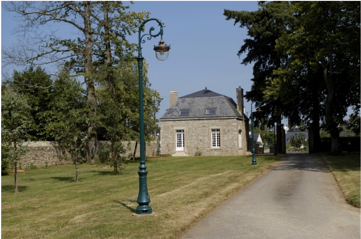
Pavillon d'entrée, vue générale sud
