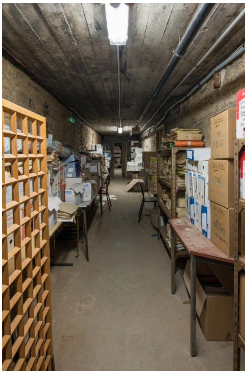
Vue du sous-sol en 2019. Noter la structure porteuse en béton armé des planchers.
