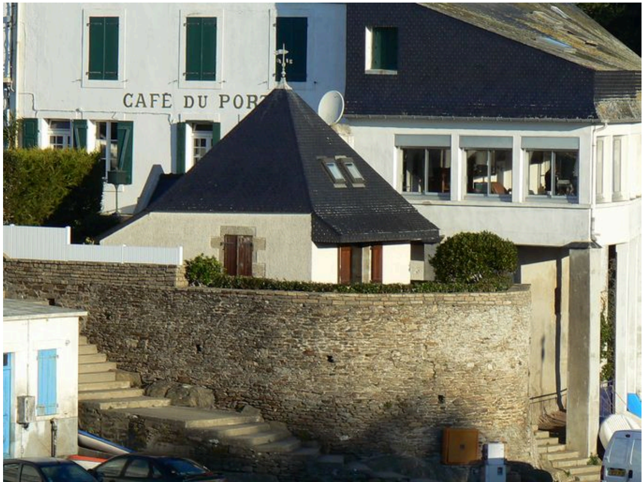
Corps de garde amont
