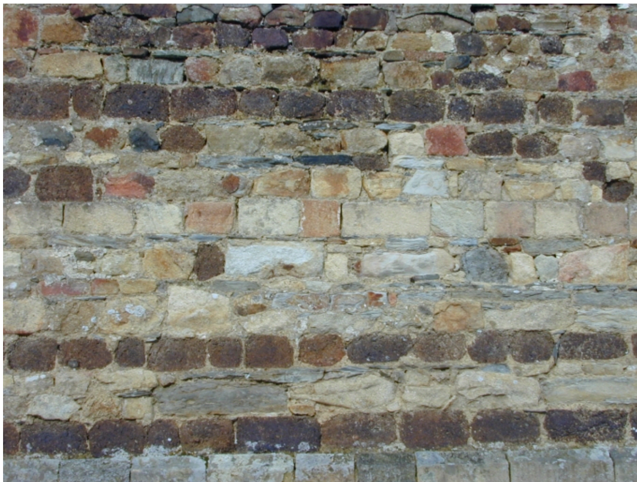
Appareillage du croisillon sud : détail
