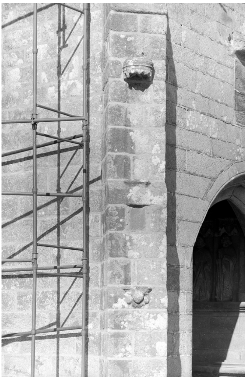
Porche sud, détail : niches à dais du contrefort sud ouest
