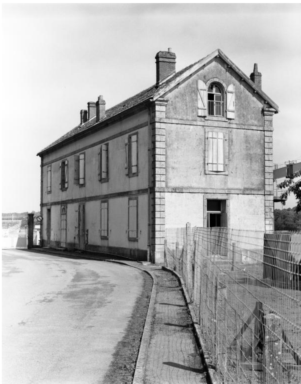
Maison de gardien, vue générale sud-ouest (état en 1998)
