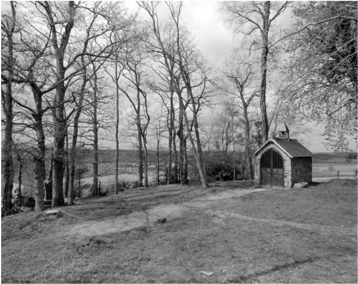
Elévation Ouest : vue de situation
