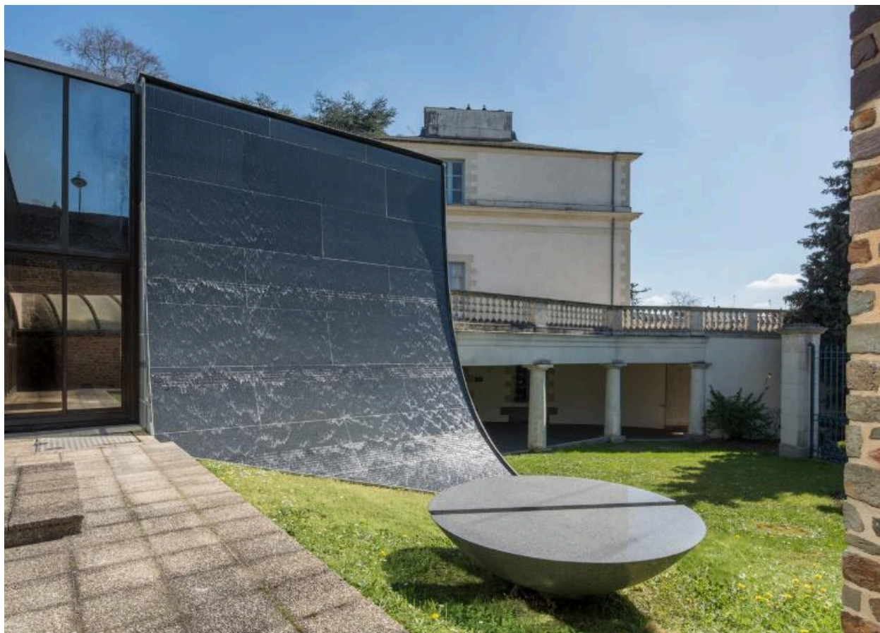
"Mur d'eau" et sculpture, Marta Pan, 1985 : vue d'ensemble, prise de l'ouest-nord-ouest.
