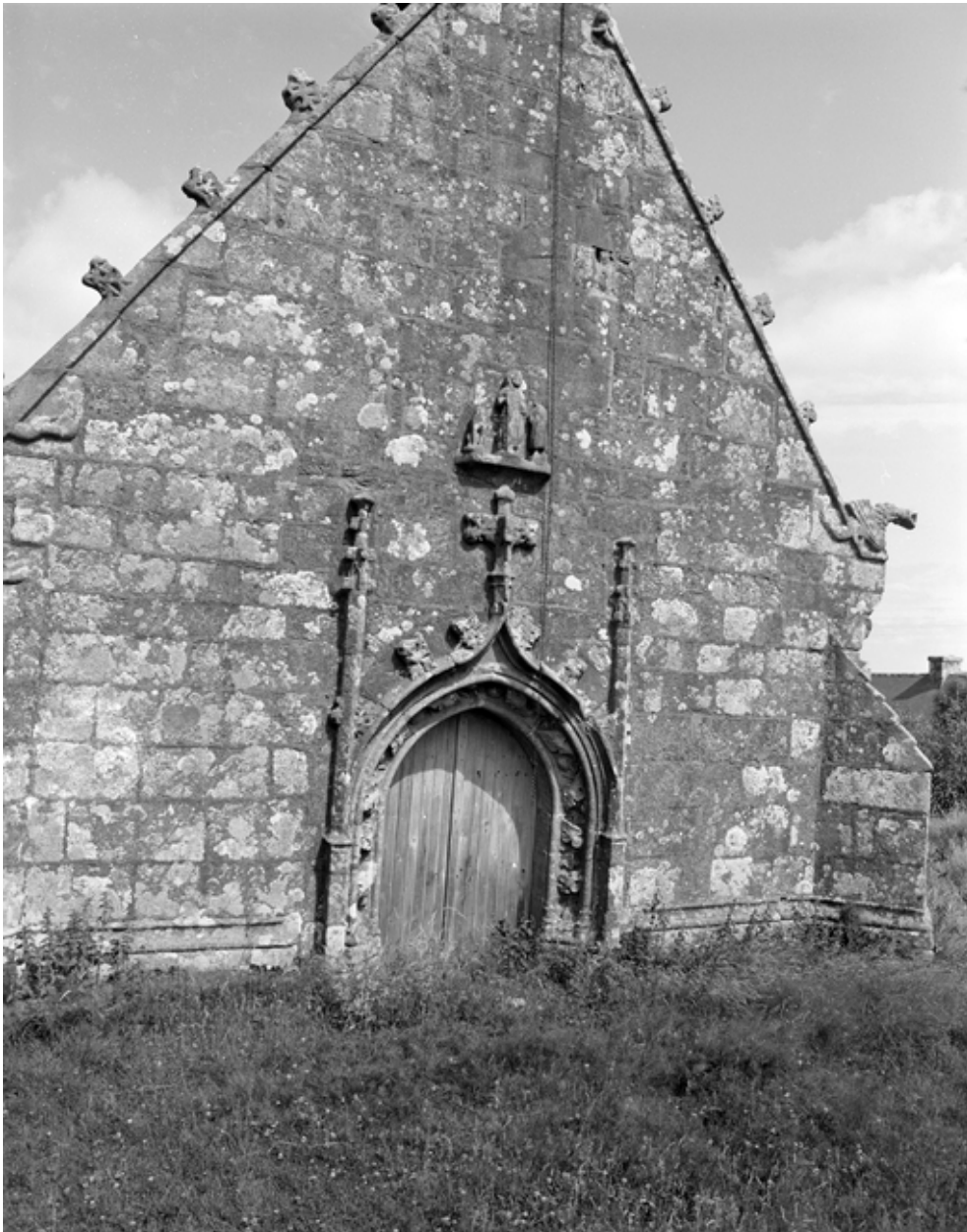
Face ouest : détail de la porte
