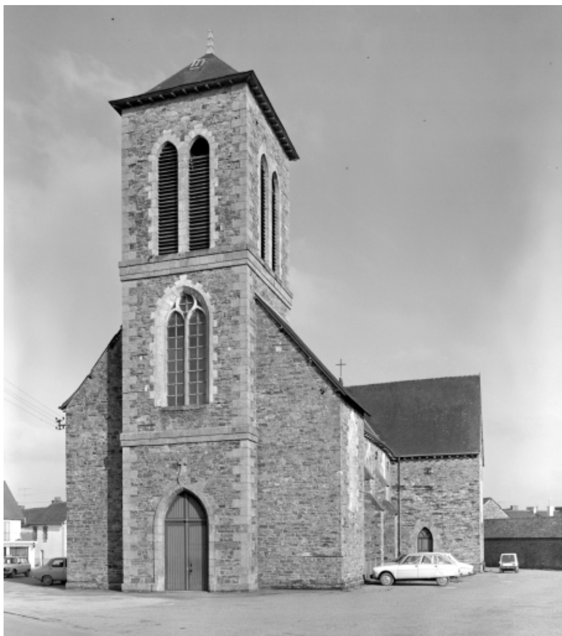
Elévation ouest : vue générale
