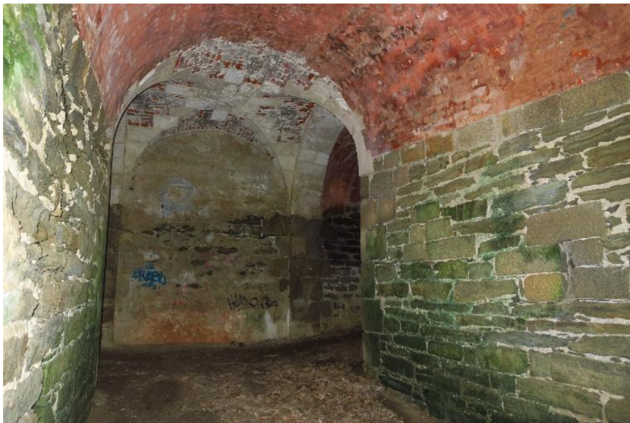
Le Palais, enceinte urbaine, réduit H, grande galerie, carrefour.
