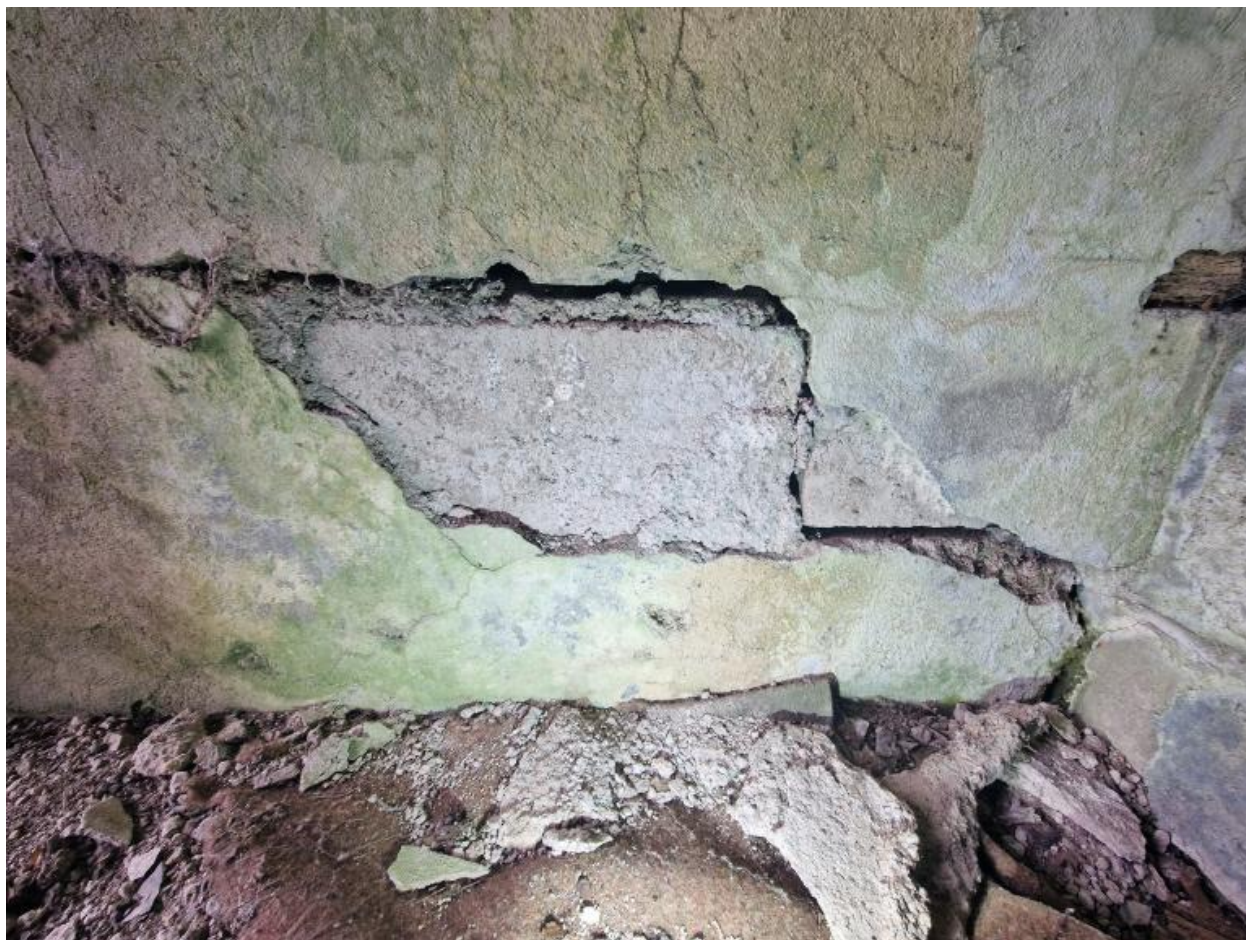
Vue du mur ouest en parpaing plein du vestibule
