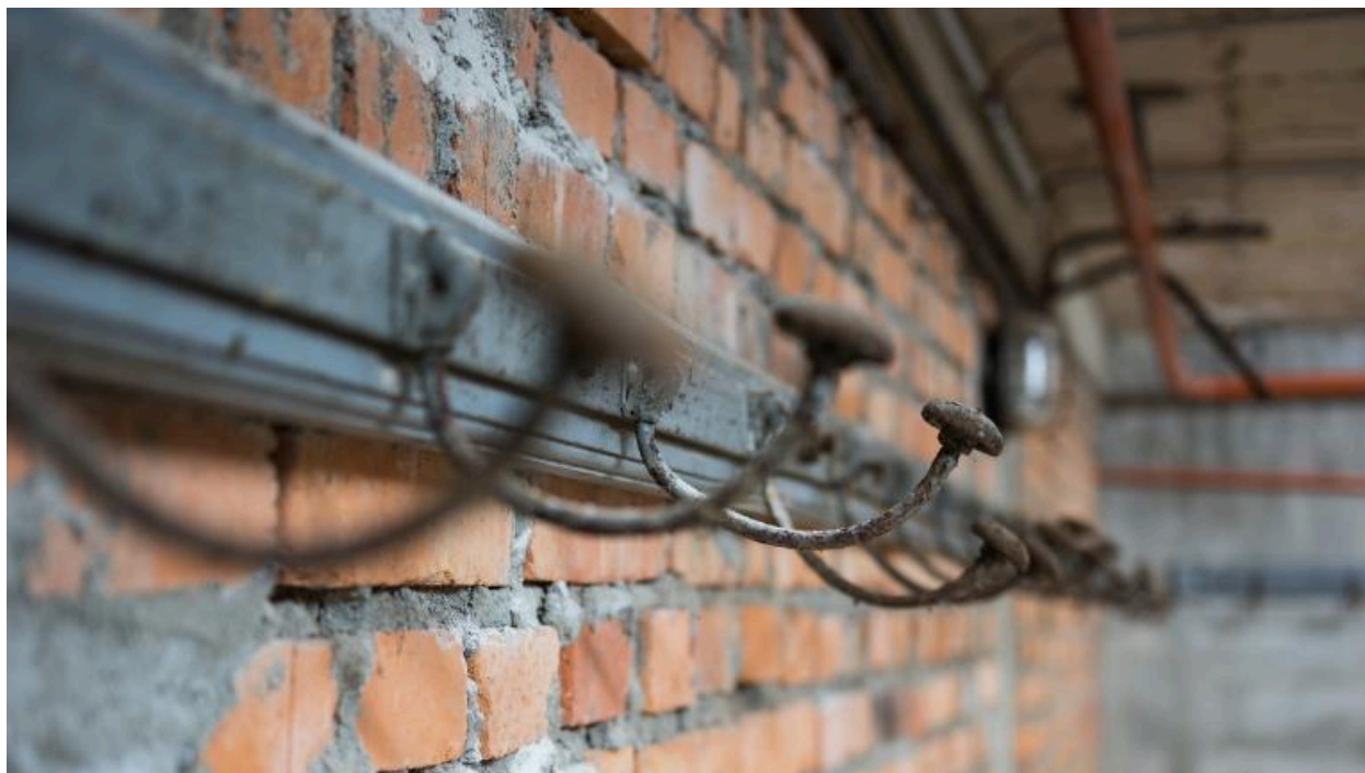
Sous-sol. Structure en béton armé, cloisons en briques et porte-manteaux : détail.
