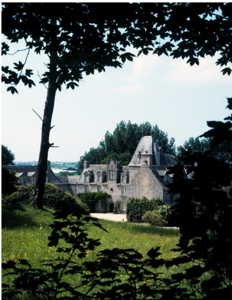
Vue de situation prise de l'est
