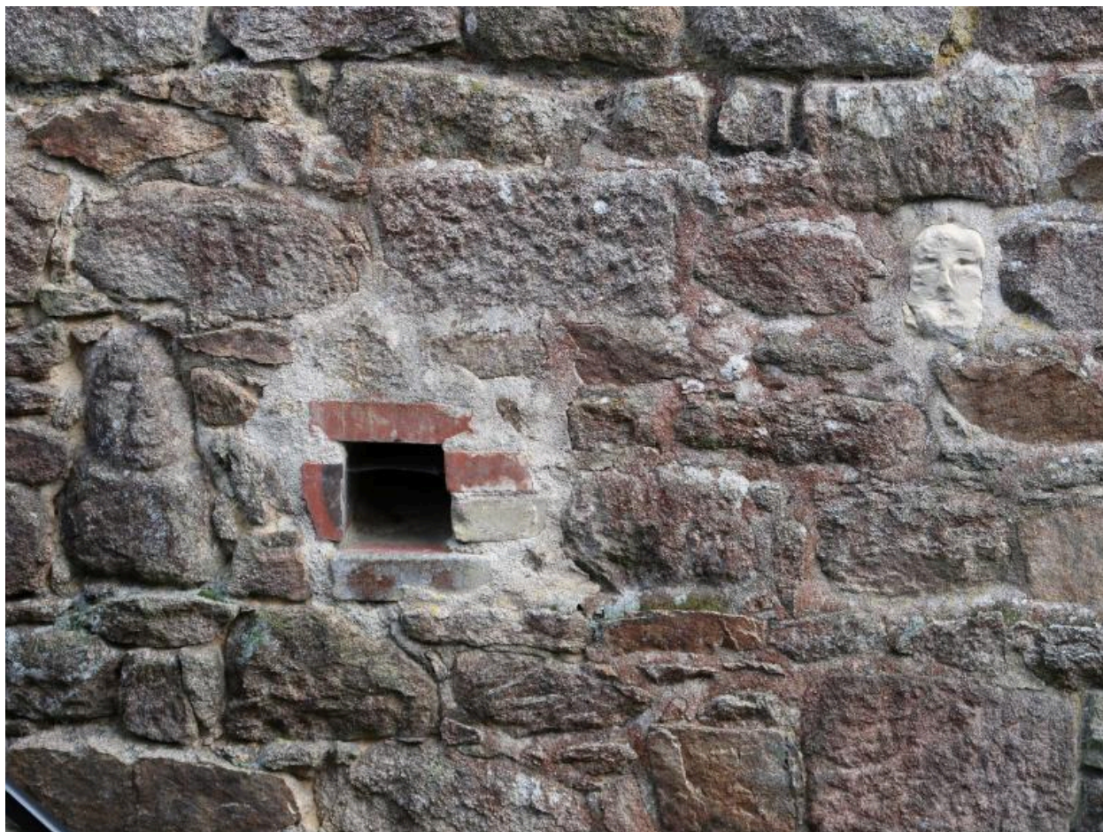
Loguivy-Plougras, le bourg : Moulin à eau de Traou an Dour, élévation ouest, détail des remplois intégrés à la maçonnerie (têtes sculptées dans du granite et du calcaire)
