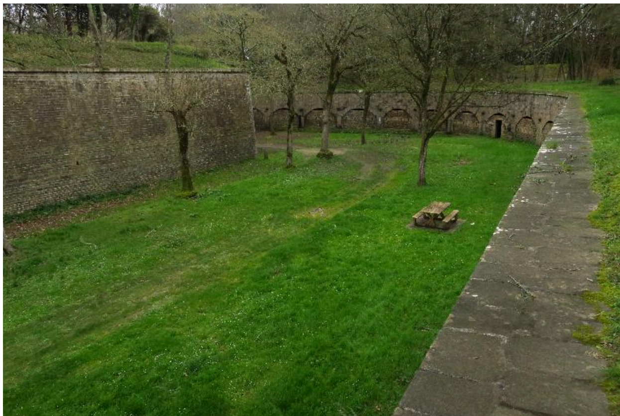
Le Palais, enceinte urbaine, galerie de contrescarpe, arrondi du bastion 20.
