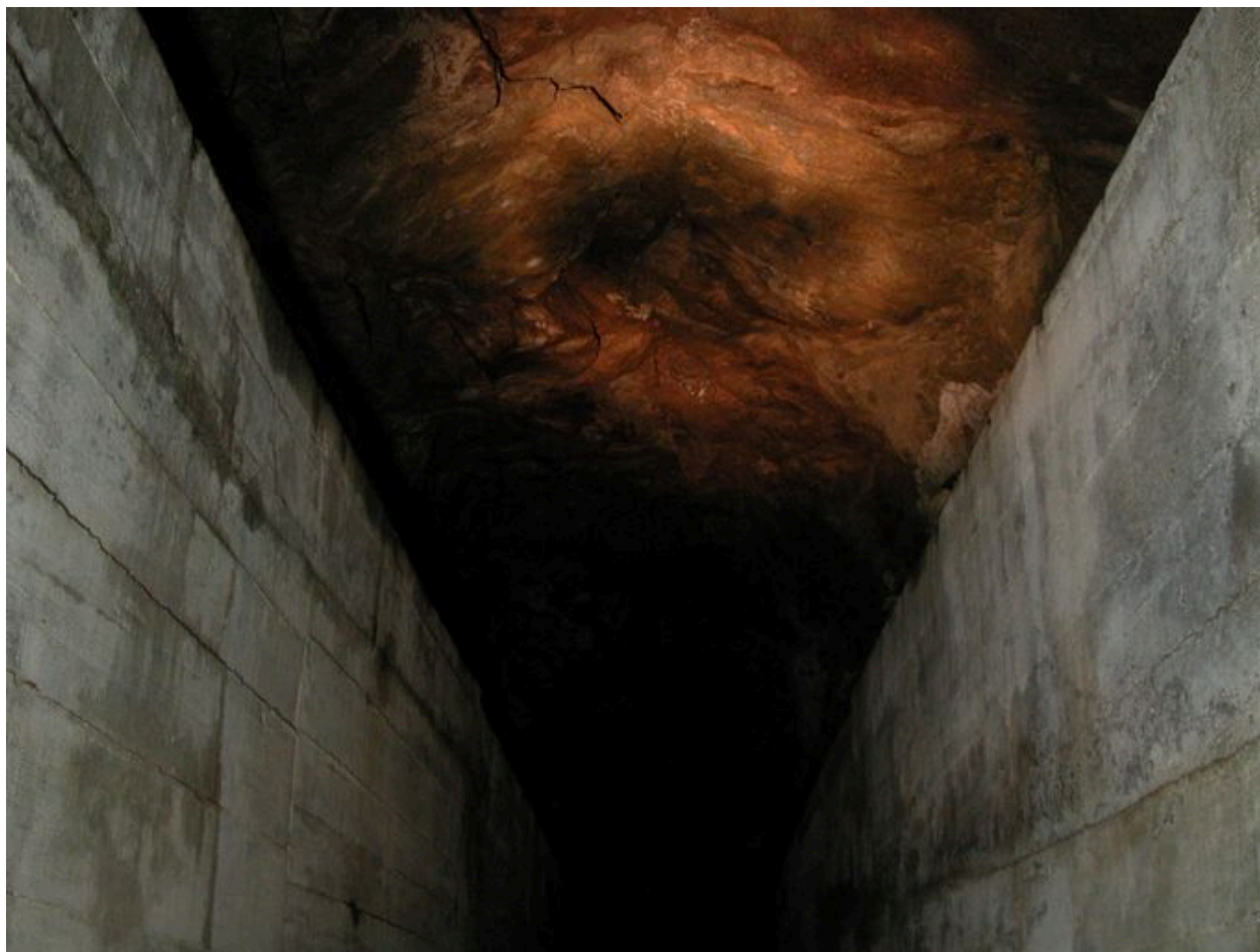
Vue intérieure du tunnel
