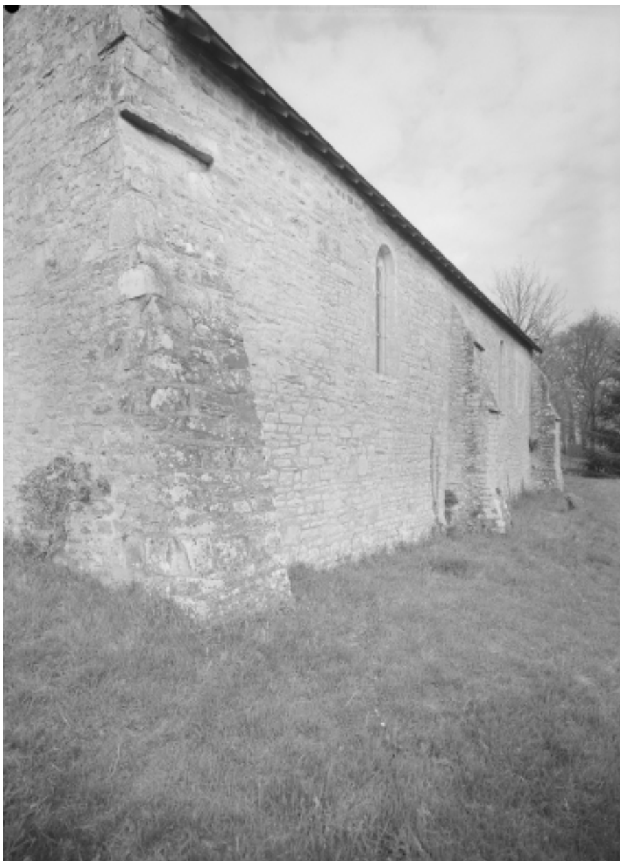
Elévation Sud : vue générale
