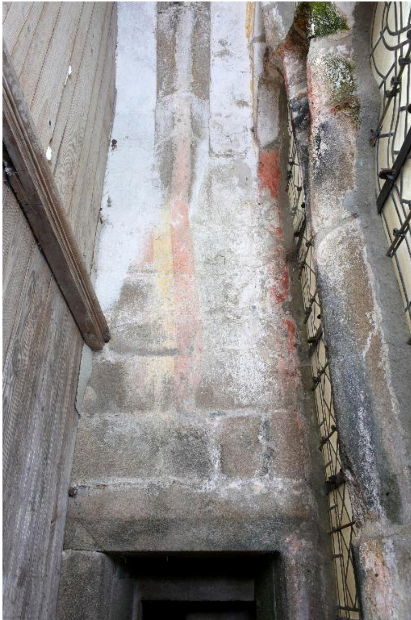
Revers façade occidentale, ébrasement, vestiges de décor peint.
