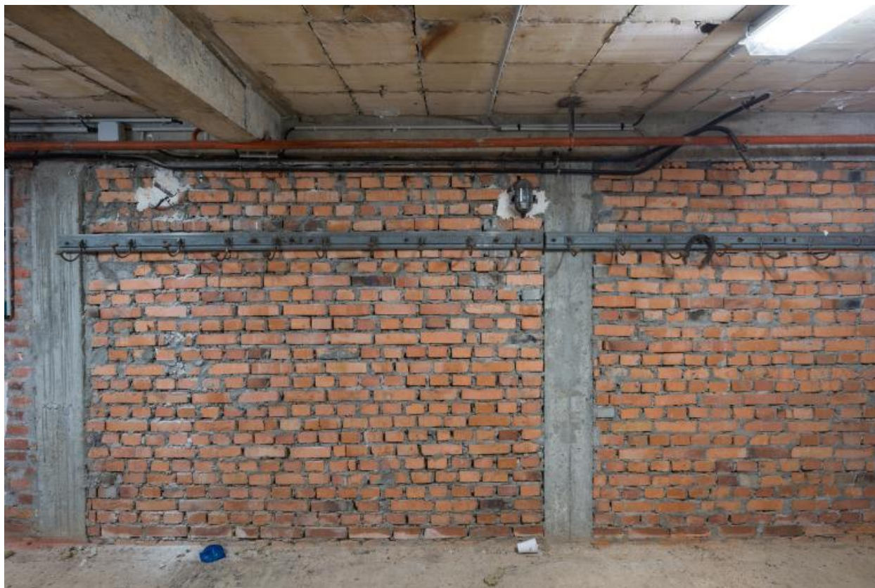
Sous-sol. Structure en béton armé, cloisons en briques et porte-manteaux.
