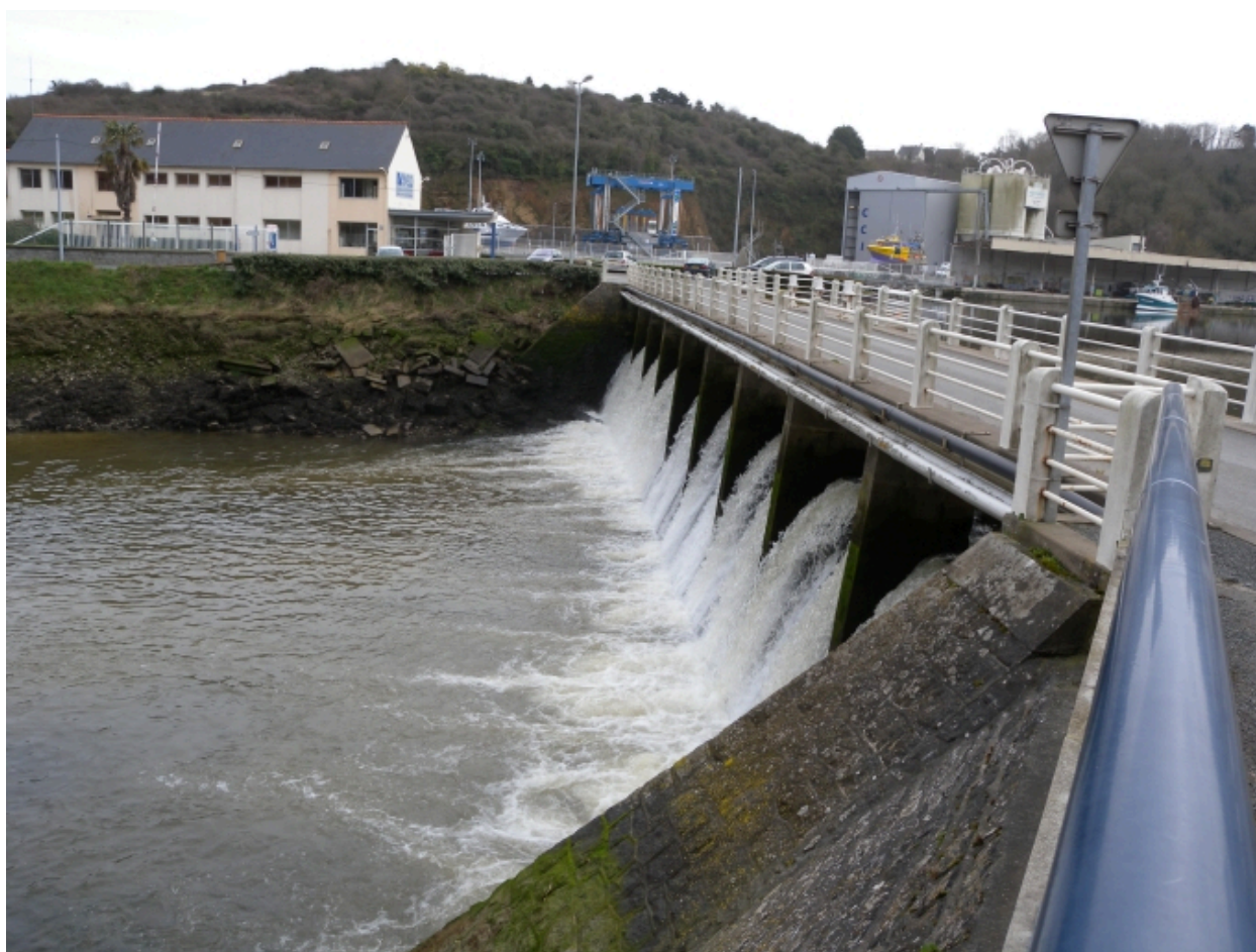
Vue du barrage-déversoir situé entre la 'presqu'île' des Ponts-et-Chaussées' et le mur de quai de rive gauche
