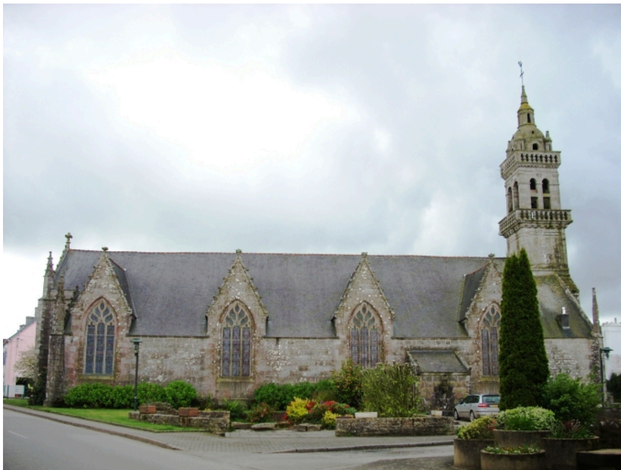
Plonévez-du-Faou, église paroissiale Saint-Pierre : élévation nord
