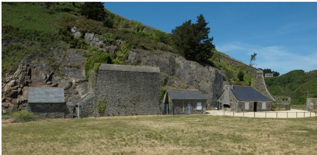
Plouzané : vue du fort du Mengant, corps de garde
