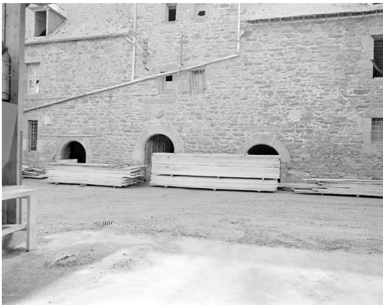
Façade principale, partie centrale : ouvertures.
