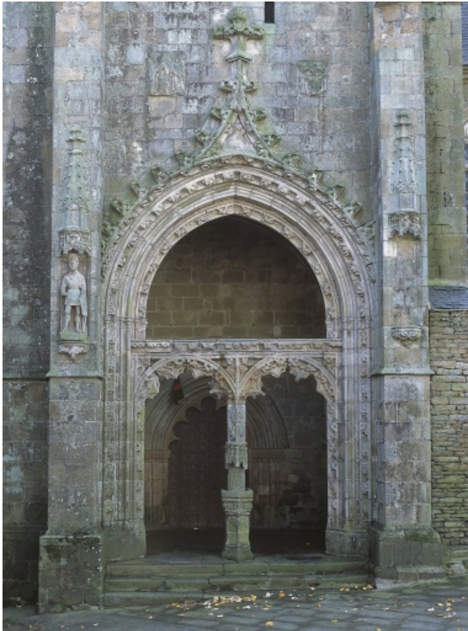
Porche nord, vue générale
