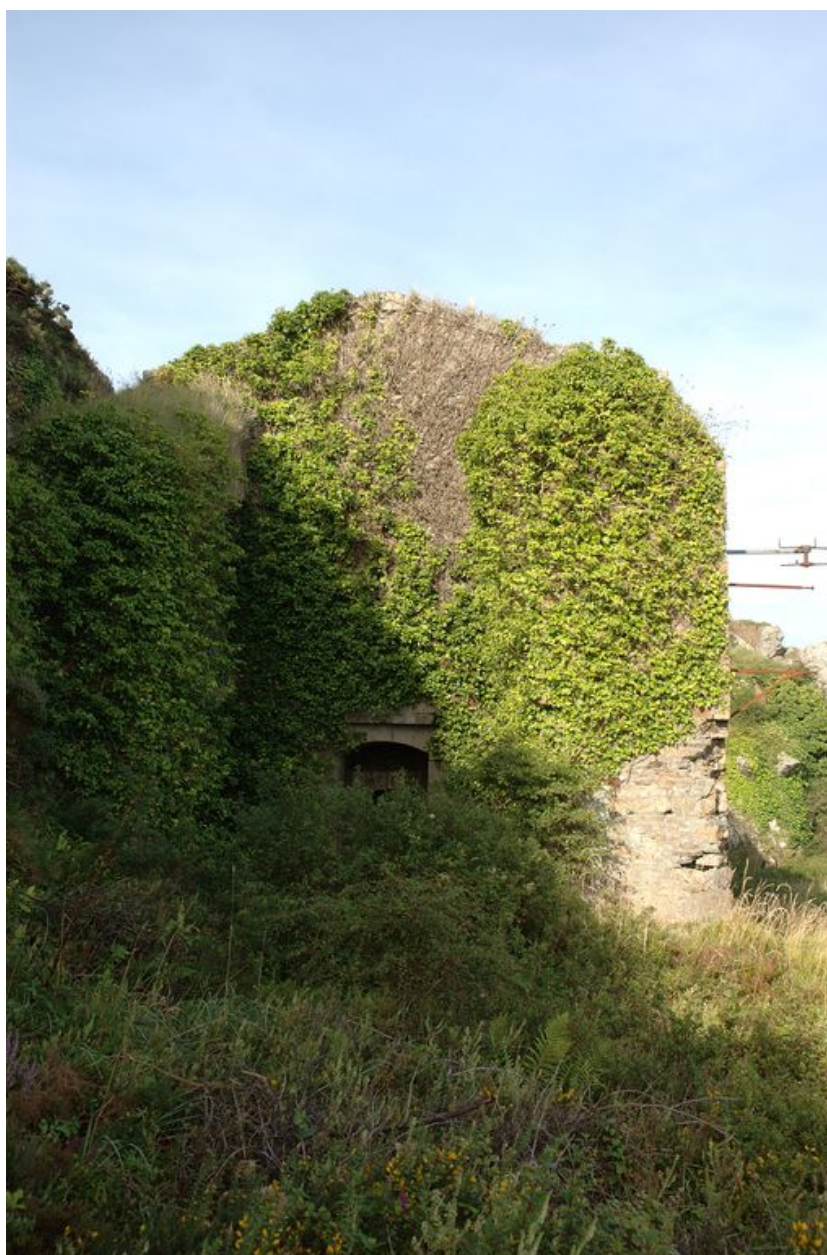
Vue générale de la caserne défensive Robert : élévation est, entrée
