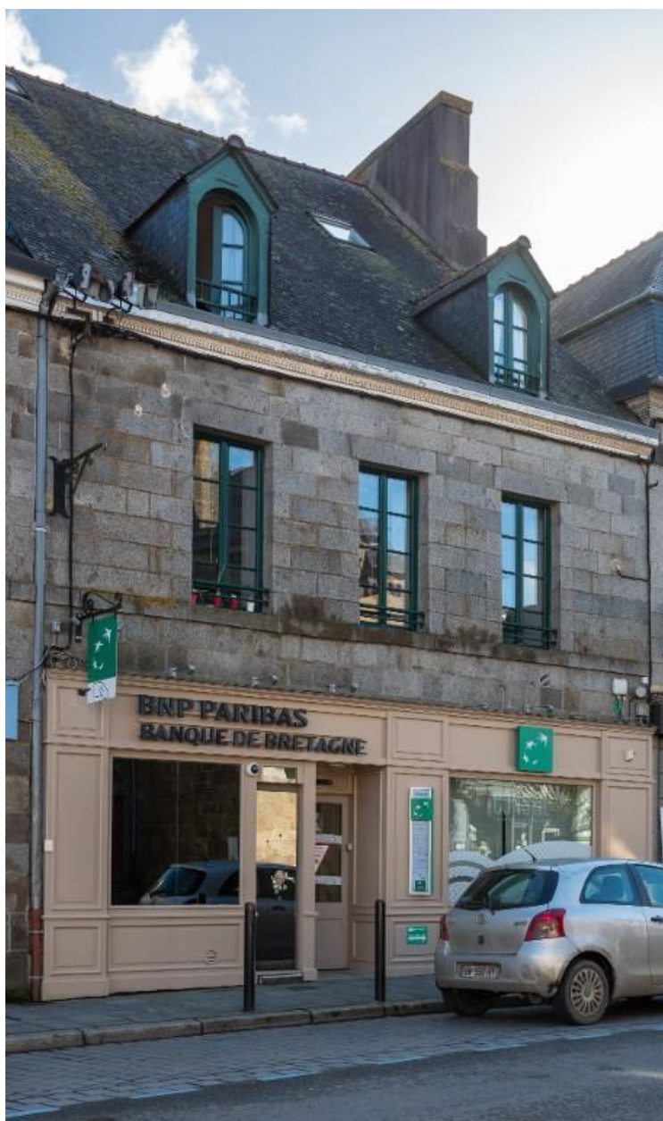
Façade principale sur rue en pierre de taille soigneusement assisées (état en 2025).
