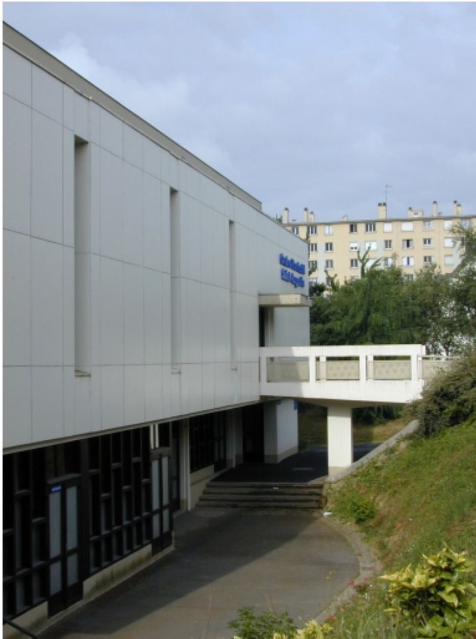
Vue de l'étage de soubassement
