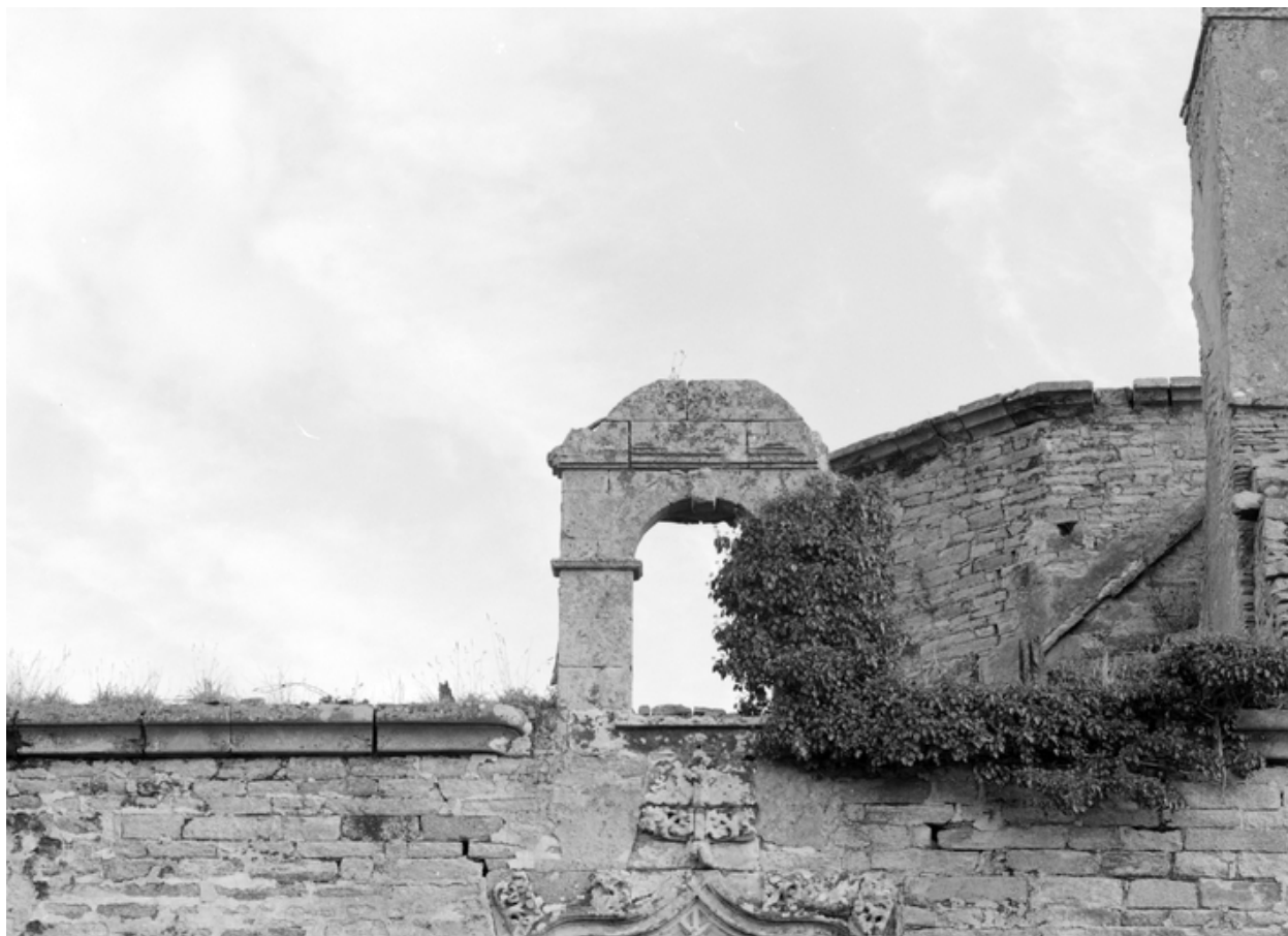
Elévation antérieure, lucarne droite.
