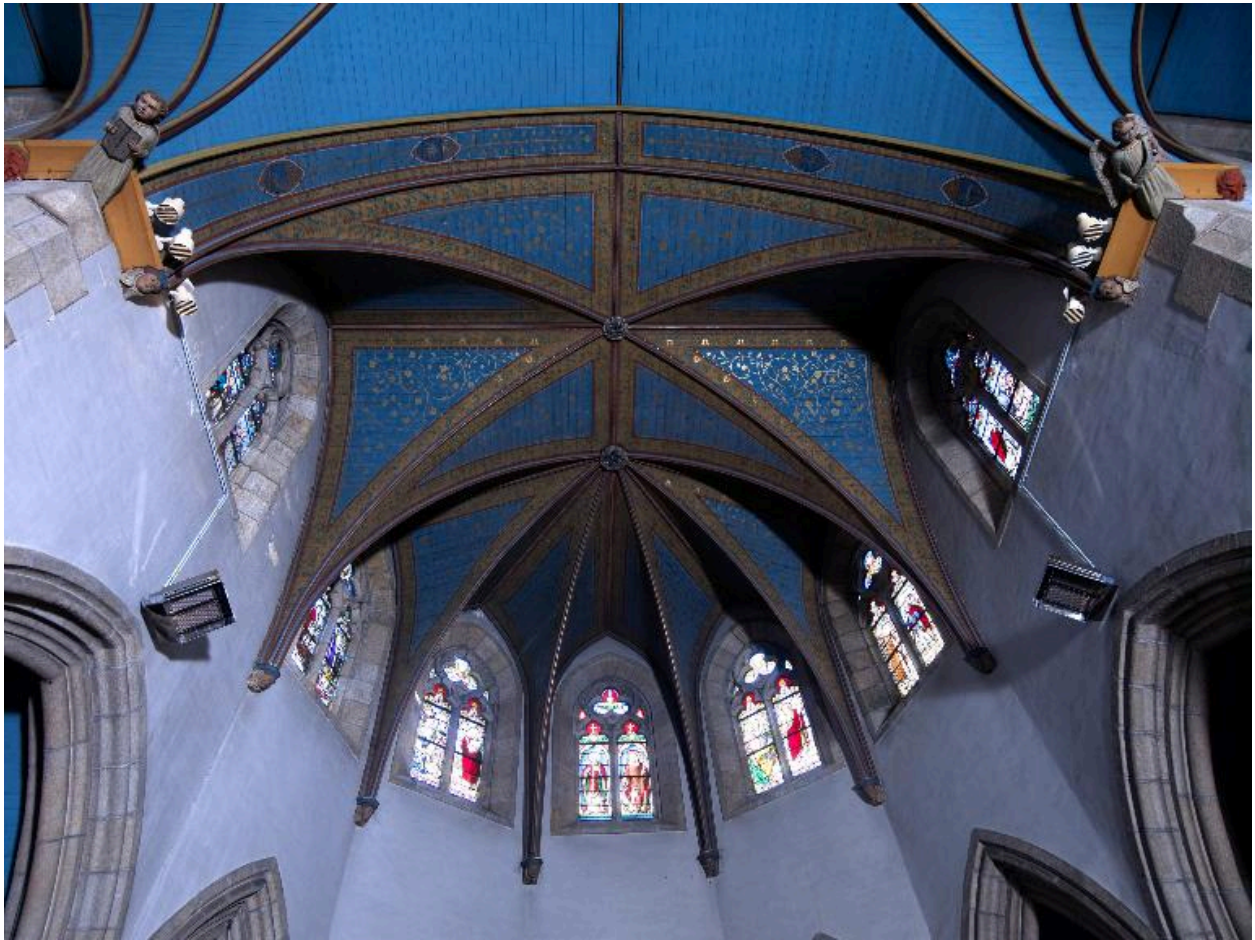
Eglise Saint-Idunet, vue de la voûte du chevet (bois polychrome)
