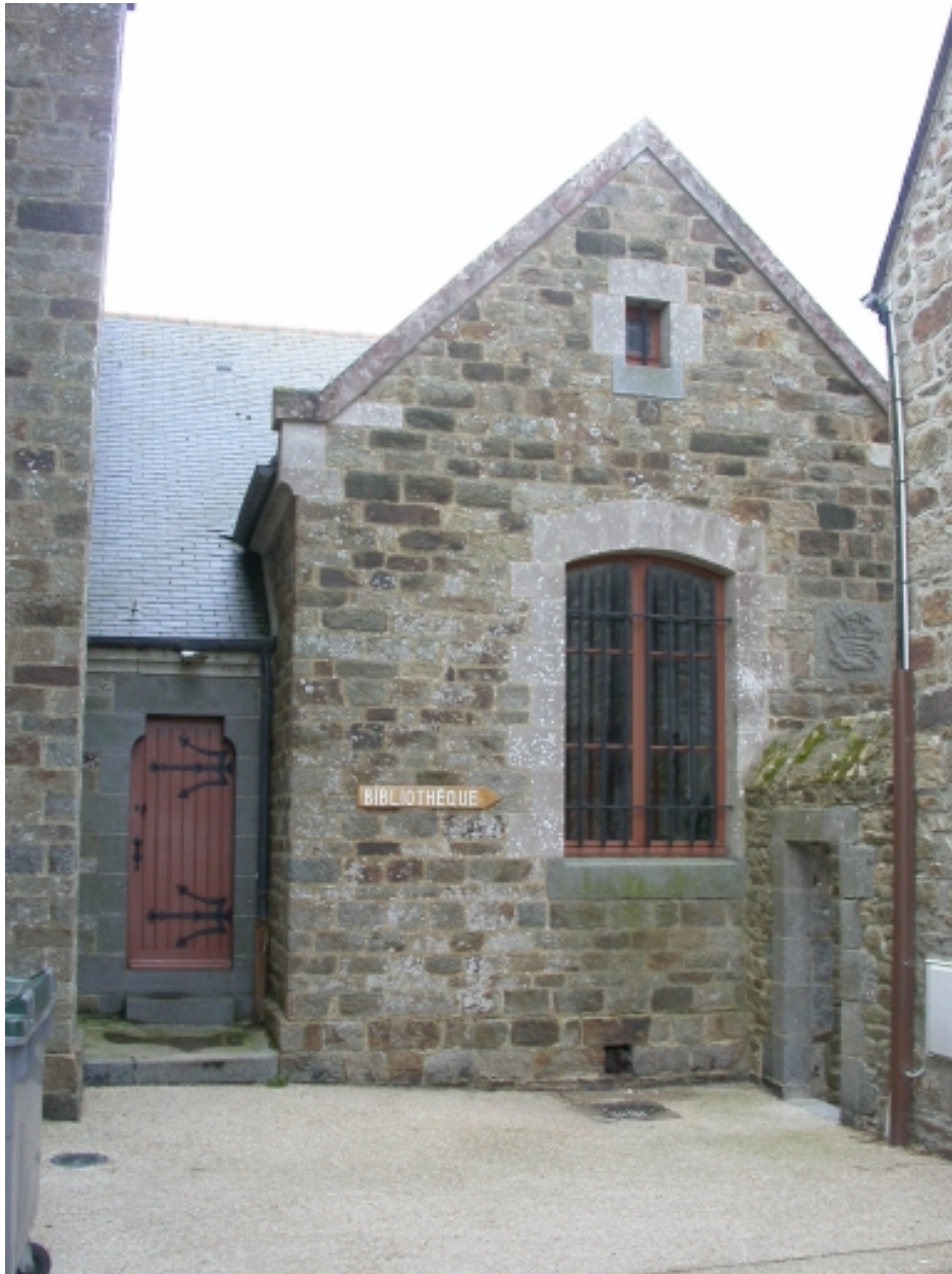
Vue de l'élévation nord de la sacristie
