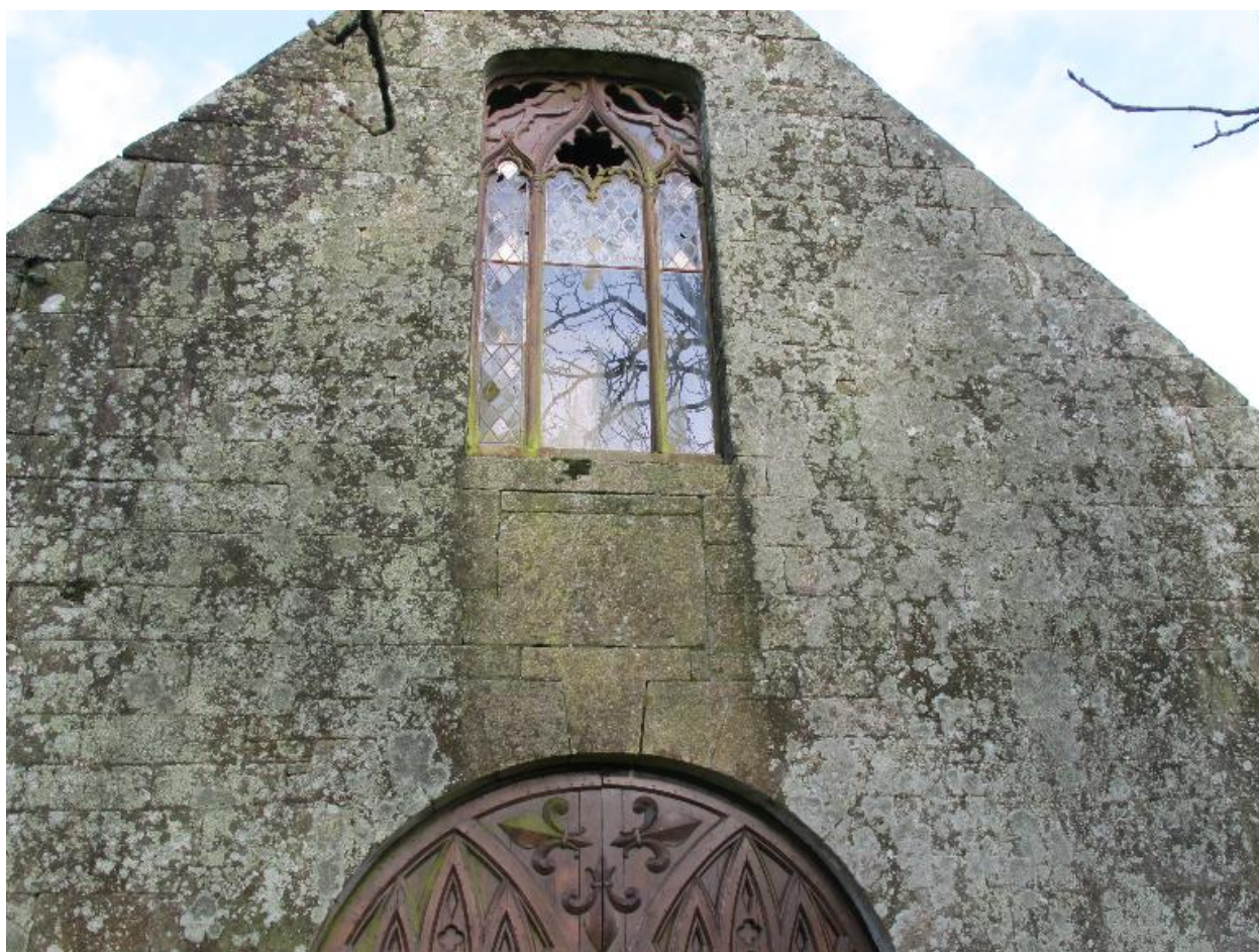
Remise au sud du logis, pignon sud, détail, état en 2015
