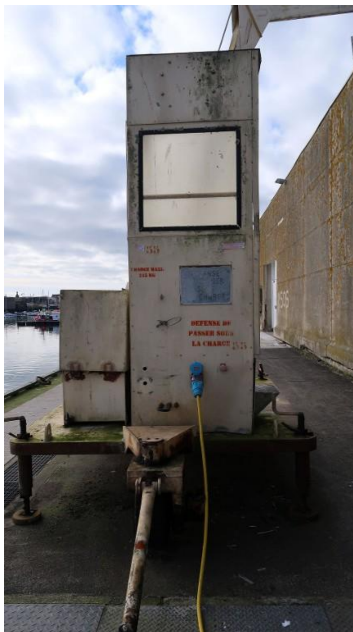
La criée de Concarneau : grue de déchargement
