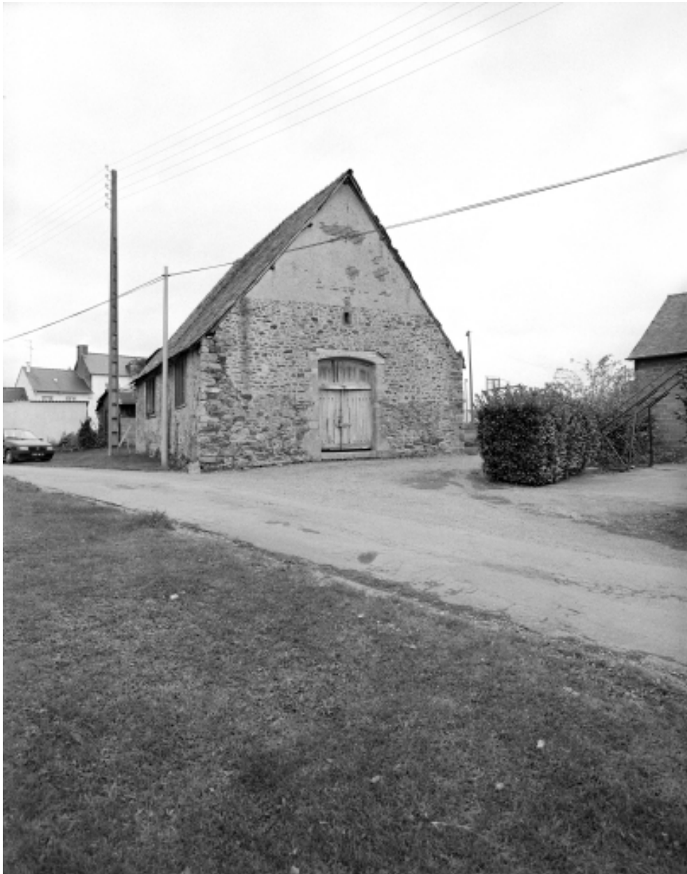
Vue générale ouest ; état en 1992
