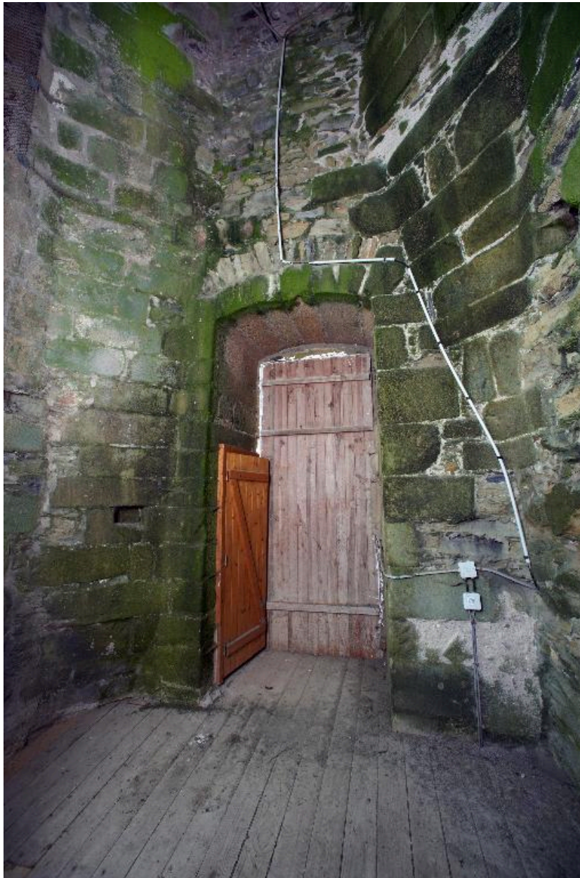
Tour sud-ouest, pièce de l'étage, revers de la porte haute pour hisser les cloches.
