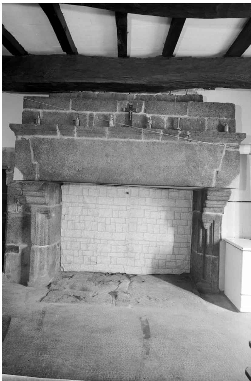
Vue générale de la cheminée du logis
